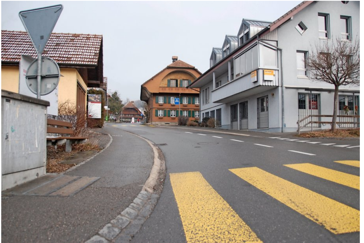
Die Oberdorfstrasse in Seftigen: Die Trinkwasserleitung, die in ihrem Untergrund verläuft, muss saniert werden.
